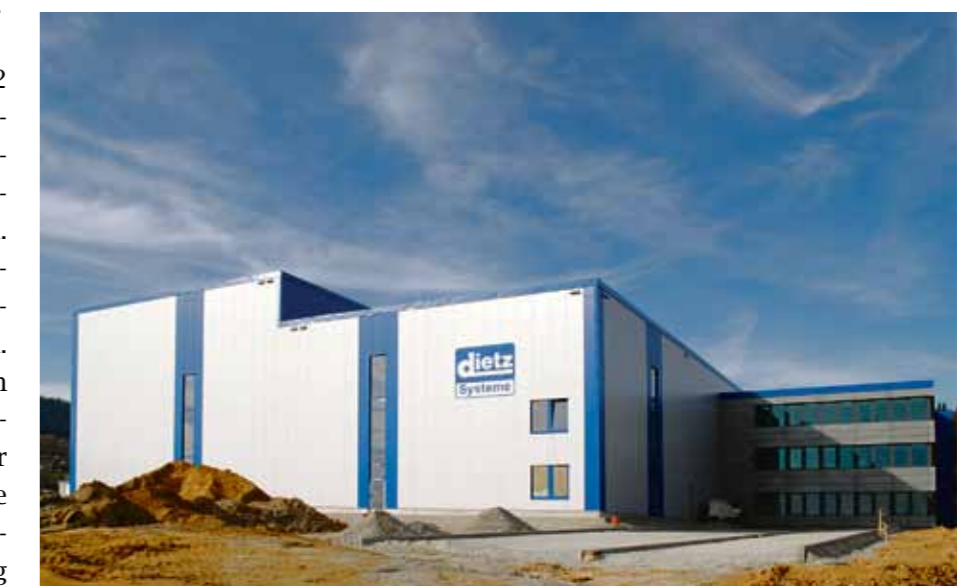
Mit seinem Neubau schafft das Unternehmen doppelt so viel Produktionsfläche wie bisher: 6400 Quadratmeter.
