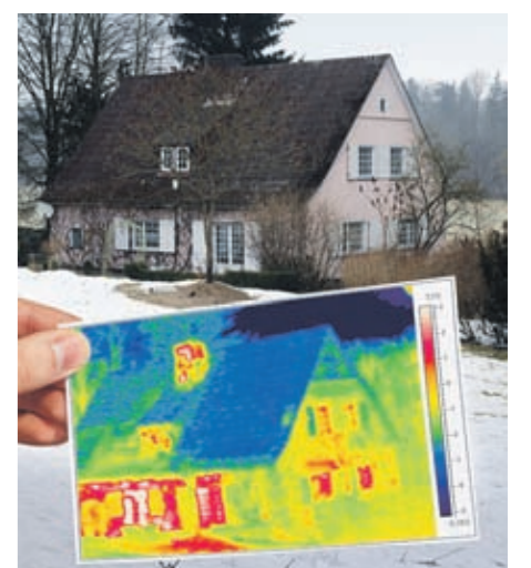
Eine thermographische Aufnahme per Wärmebildkamera verdeutlicht, an welchen Stellen eine Immobilie Energie verliert.
